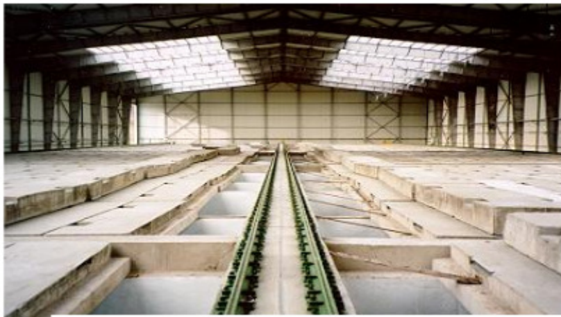
Abbildung 10: Lagerhalle in Mochovce (JAVYS 2010)
